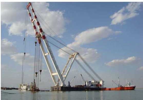
【A new Floating Crane – 2,000t】
