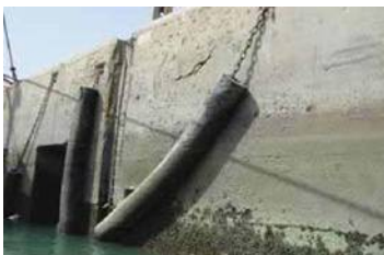
【Berth before fender installation】
