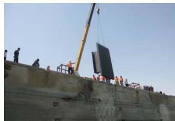
【Fender installation】
